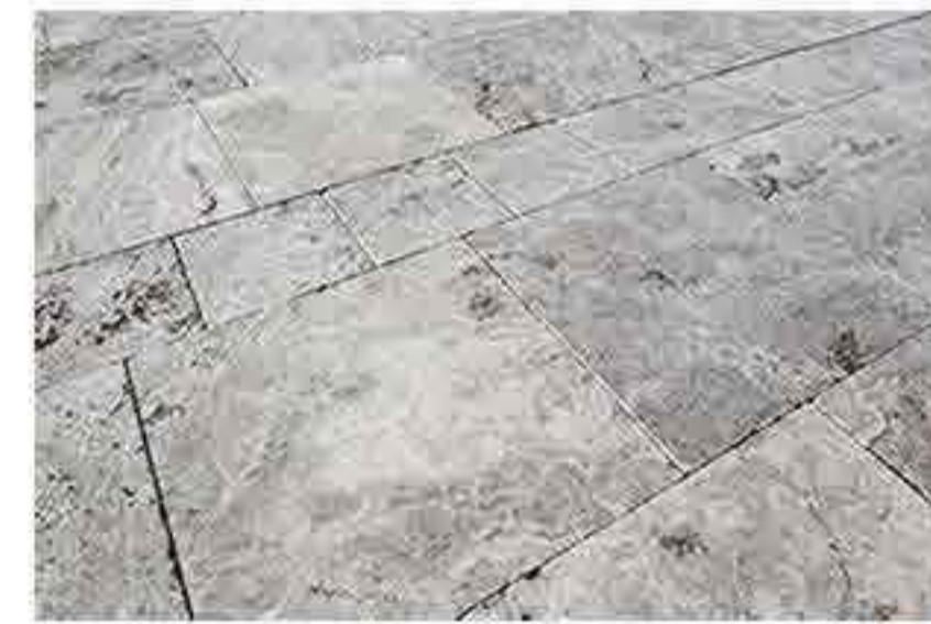
Mauern aus Travertin
